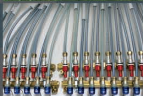
Verteiler einer Fußbodenheizung
