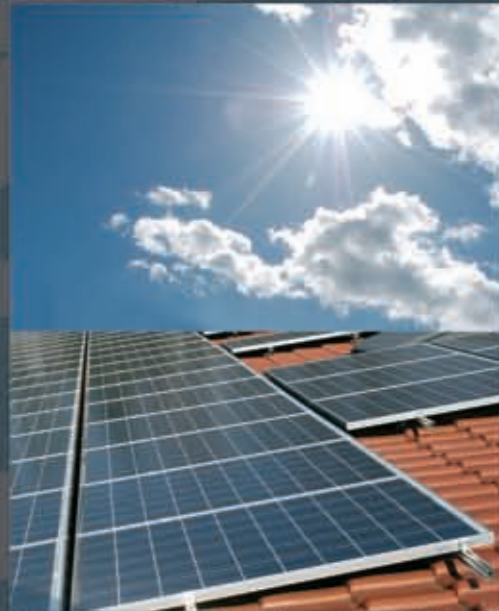
Auf dem Dach installierte Solaranlage
