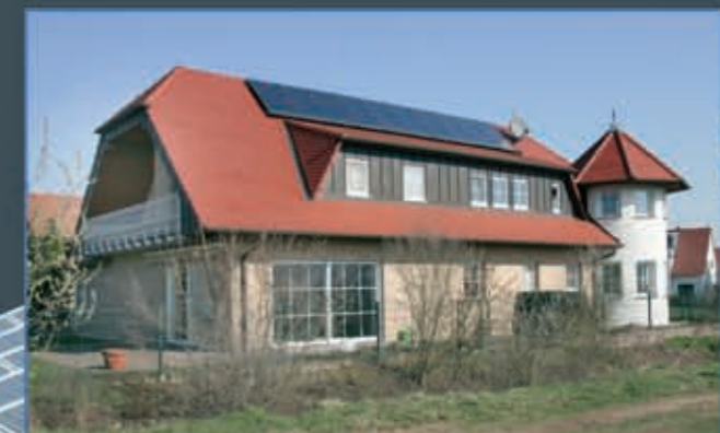
Einfamilienwohnhaus mit solarer Warmwasserbereitung und Heizungsunterstützung
